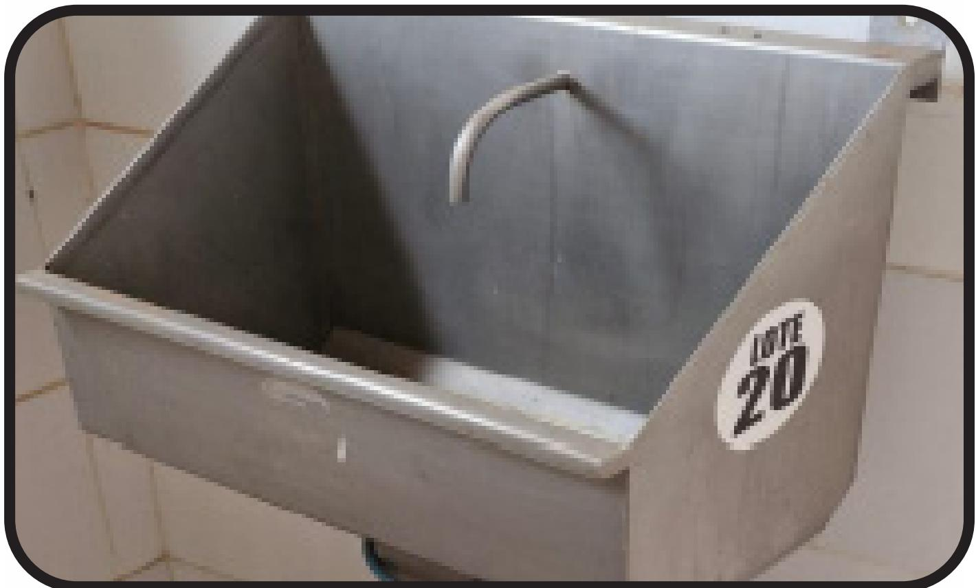
**Lavatório Inox com Acionamento por Joelho – Modelo Sanitário de Parede Marca CARNOX**
