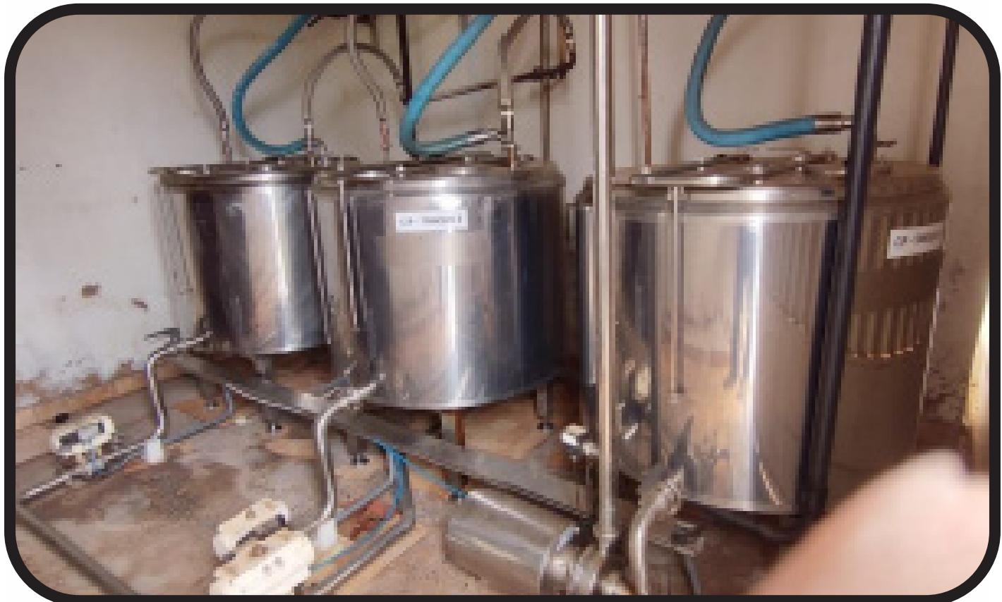
**Sistema CIP (Cleaning In Place) – Conjunto de Limpeza Automática Sanitária 1º TANQUE ÁCIDO / 2º TANQUE SOLDADA / 3º TANQUE ÁGUA**
