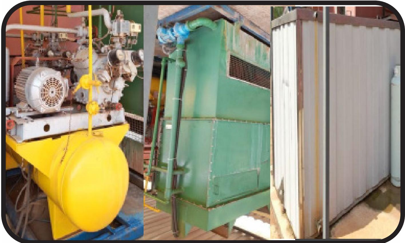
**Unidade de Refrigeração Industrial com Condensador Evaporativo e Reservatório Isotérmico.**
