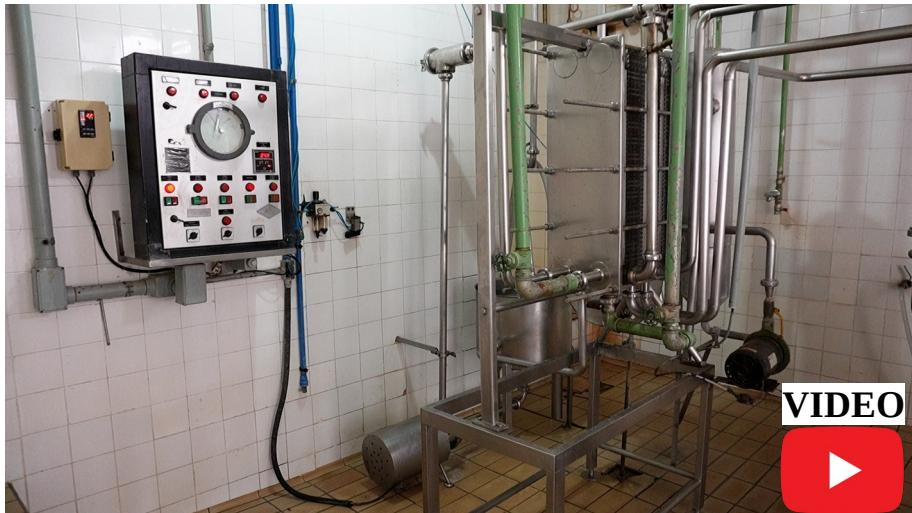
TIPO: PASTEURIZADOR RÁPIDO A PLACAS (HTST - HIGH TEMPERATURE, SHORT TIME).
